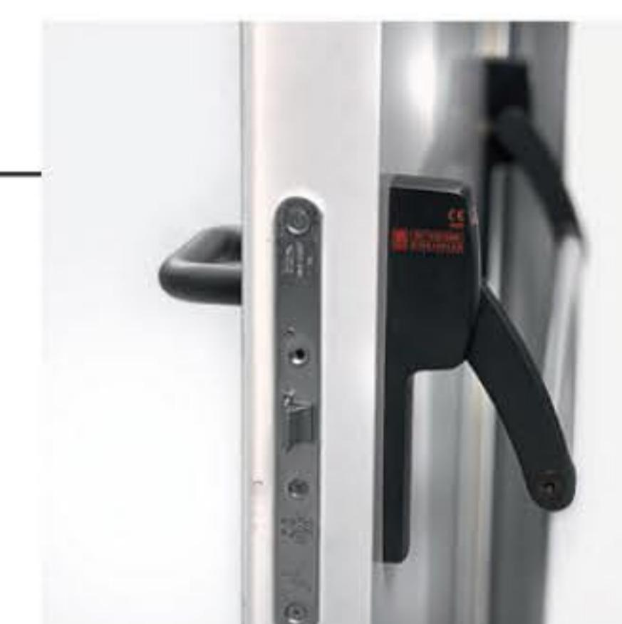
All'interno delle ante, sul lato a spingere, viene montato sempre un rinforzo, per migliorare la struttura della porta in caso del montaggio del maniglione anche in un secondo tempo.
